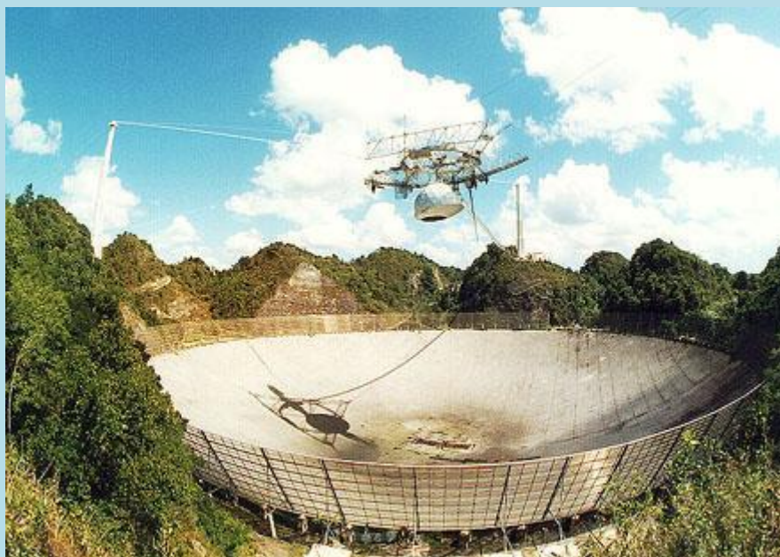
Радиотелескоп в Аресибо с диаметром зеркала в 305 метров. Взято отсюда .
