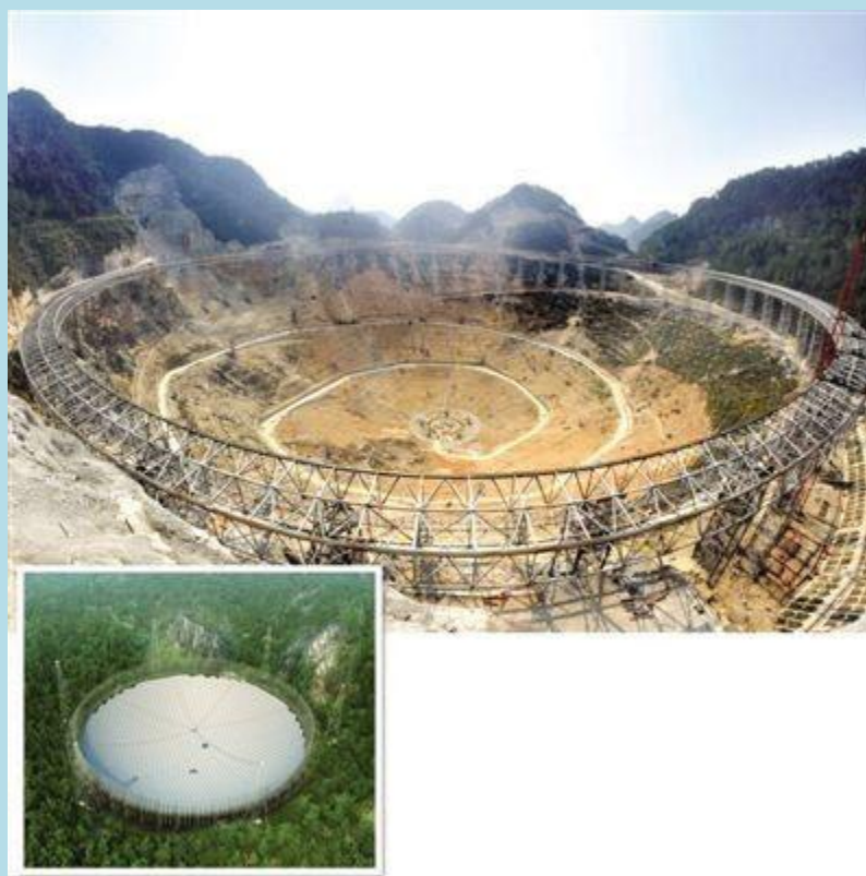
Строительство радиотелескопа FAST на начало 2014 года. Источник снимка.
